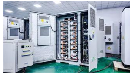
Sol-Up Solar , Premier Las Vegas Solar Provider
