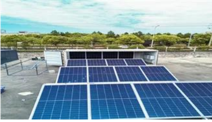
Sol-Up Solar , Premier Las Vegas Solar Provider
